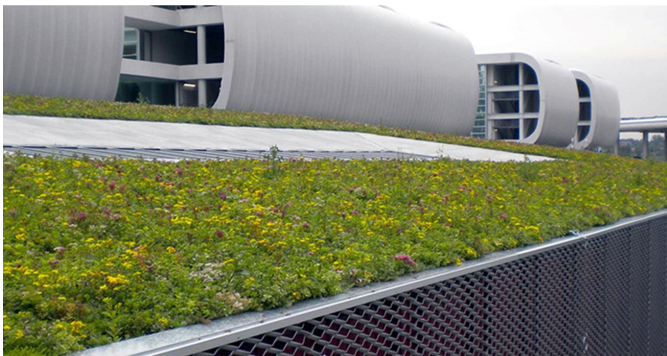
Figura 9 Tetto verde estensivo di 1000m 2 realizzato nell'aeroporto di Milano Malpensa, con strato drenante Drainroof. Le soluzioni di tetto verde estensivo si prestano bene all'inverdimento di ampie coperture e capannoni dove l'aspetto estetico può passare in secondo piano. Foto ( https://www.geoplastglobal.com/it ).
