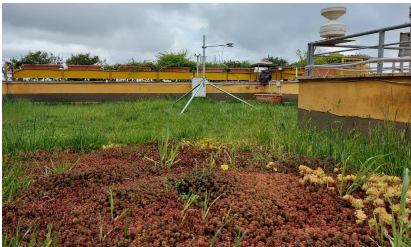
Figura 25 Tetto verde sperimentale, con tappeto di S. spurium in primo piano e prato di graminacee sullo sfondo.
