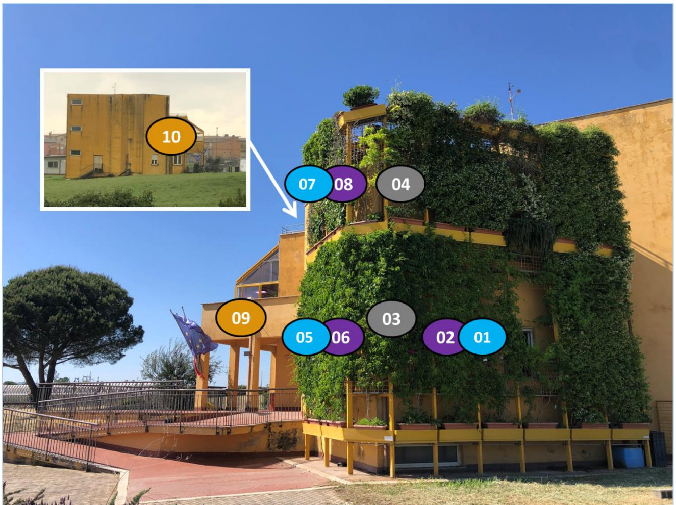
Figura 22 Collocazione dei sensori di CO 2 e O 2 , in blu i sensori posizionati tra le foglie, in viola i sensori posizionati al centro dell'intercapedine, in grigio i sensori nelle stanze, in arancione i sensori di controllo.
