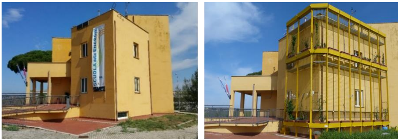
Figura 18 Green building dell'ENEA, prima e dopo l'installazione della struttura metallica di sostegno.
