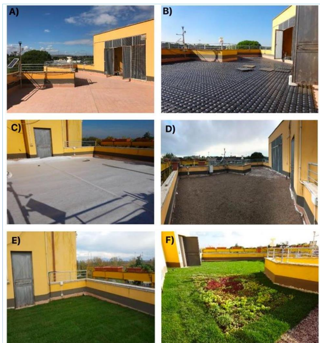
Figura 23 Fasi realizzative del tetto verde sperimentale, A) Lastrico solare prima dell'istallazione, B) Posizionamento dell'elemento drenante alveolare, C) Strato filtrante che impedisce il dilavamento del substrato negli strati sottostanti, D) Spianatura del substrato, E) Tappeto verde di graminacee ultimato, F) Area adibita al mix di Sedum ( https://www.ingenio-web.it/33827-la-tecnologia-dei-tetti-verdi-tipologie-e-stratigrafia ).
