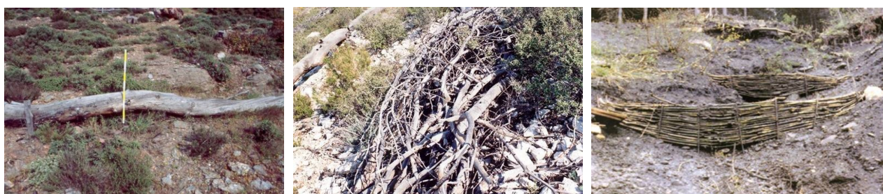
Figura 5.15 - Grecia, lavori di messa in sicurezza di aree percorse dal fuoco con materiale recuperato sul posto.
