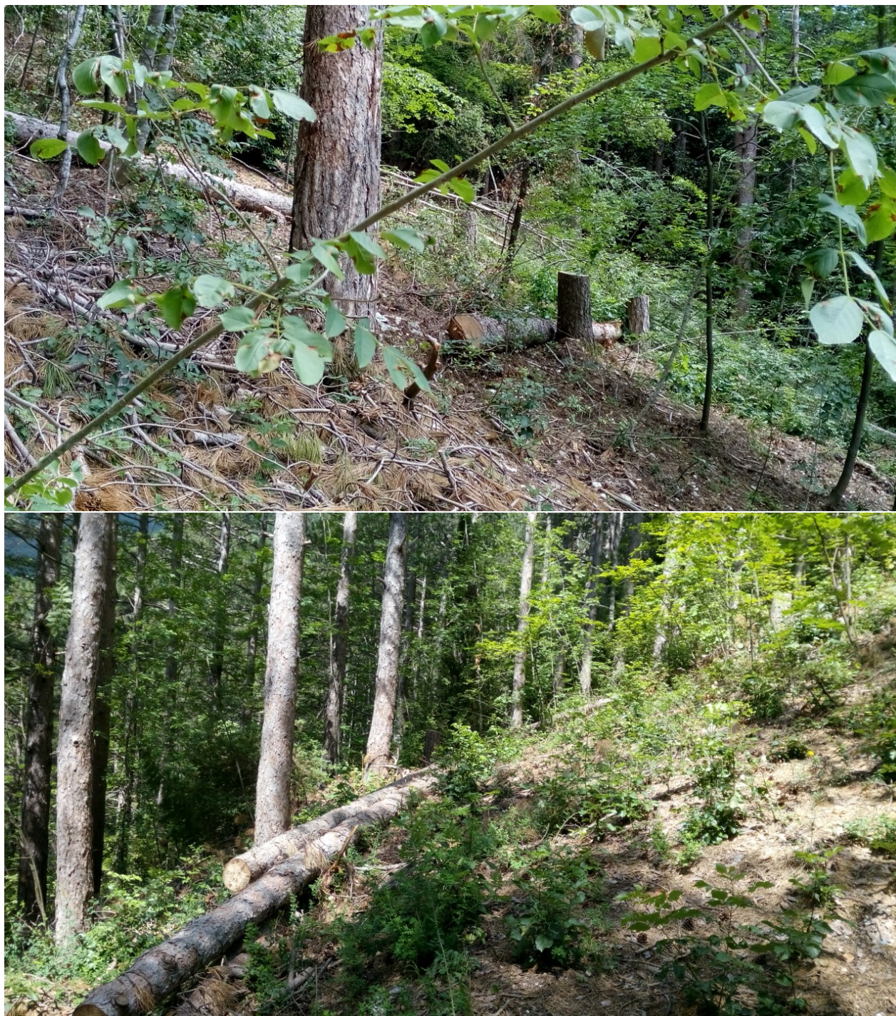
Figura 5.12 - Guardiagrele (CH), Piana delle Mele. Intervento di rinaturalizzazione di pineta artificiale. Il posizionamento di tronchi a terra variamente ancorati sul terreno, favorisce anche lo sviluppo della rinnovazione naturale a monte delle opere.
