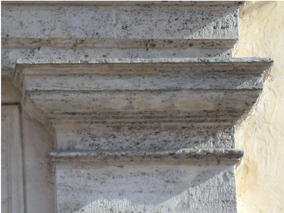
Fig. 13 The capitals of S. Stanislao facade (fot. M. Hirsch)
