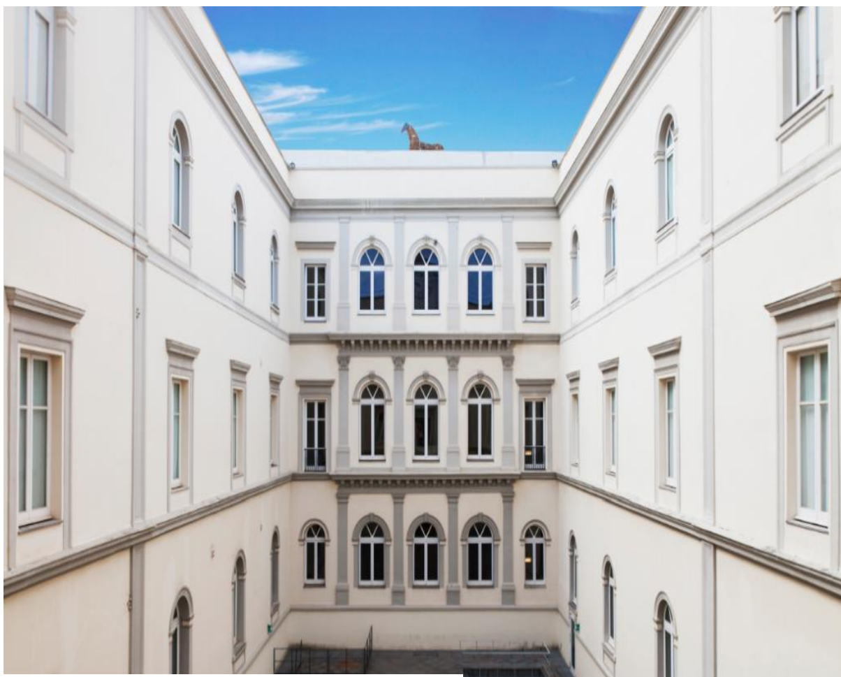
MADRE 1 Veduta del cortile interno
