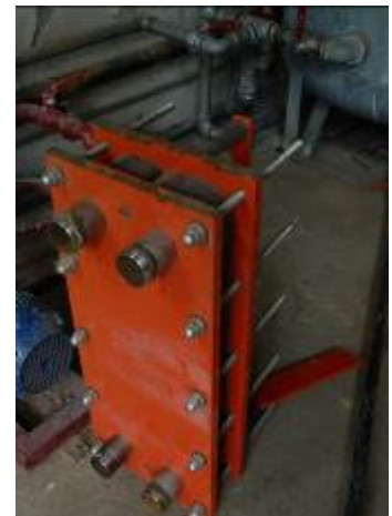
Figura 14. Scambiatore di calore a piastre
