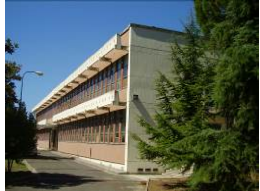
Figura 13. Edificio adibito ad uffici del CRA-ING, riscaldato a biomassa
